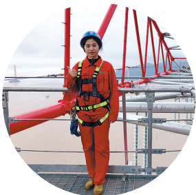
高菲在舟山500千伏联网输变电工程走线检查线路。受访者供图
